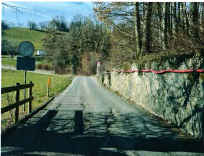
Photo 1 : Ch. de la Plantaz
